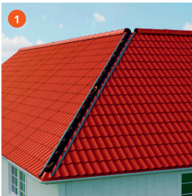
Montera tätband Universal mellannock och takpanna.
