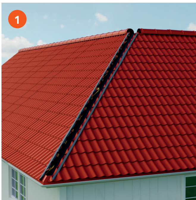
Montera tätband Universal mellannock och takpanna.
